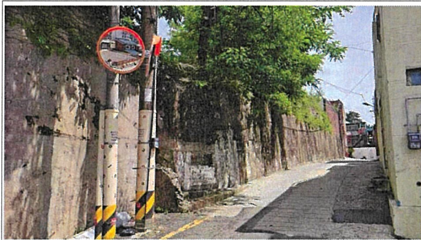
점검 응벽 전경
