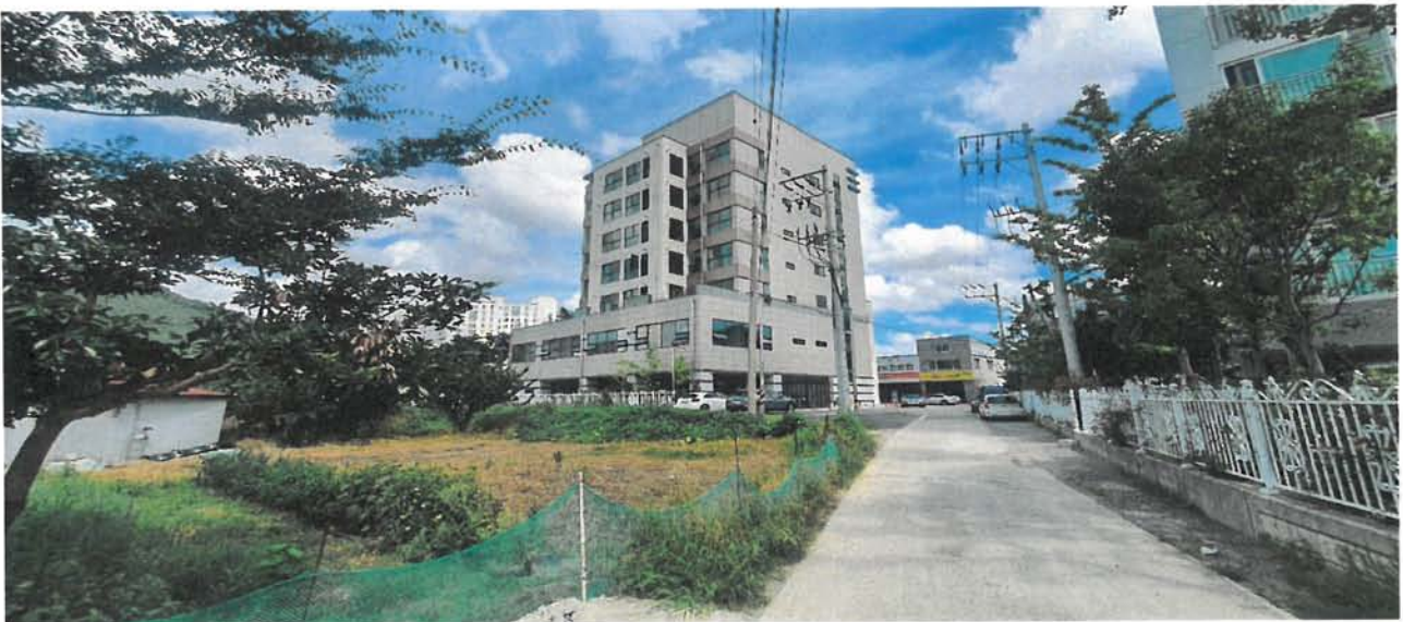
본건 외부 전경
