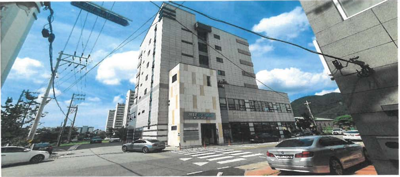
본건 외부 전경
