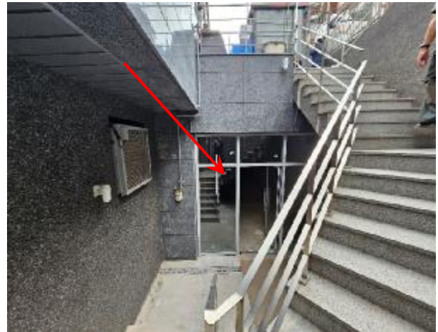
[ 본건 지하 근생 출입문 전경 ]
