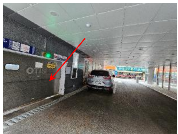
[ 본건 1층 기계식 주차장 입구 ]
