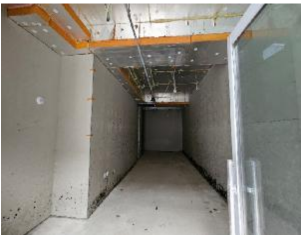
[ 본건 지하 근생 내부 전경 ]
