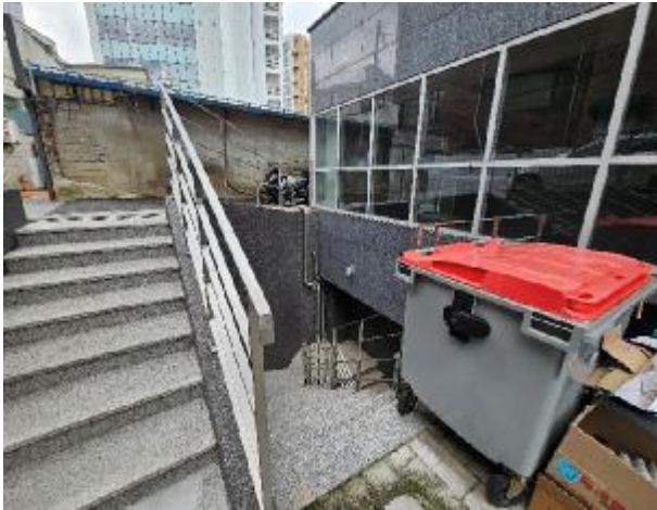
[ 본건 지하 근생 출입계단 ]
