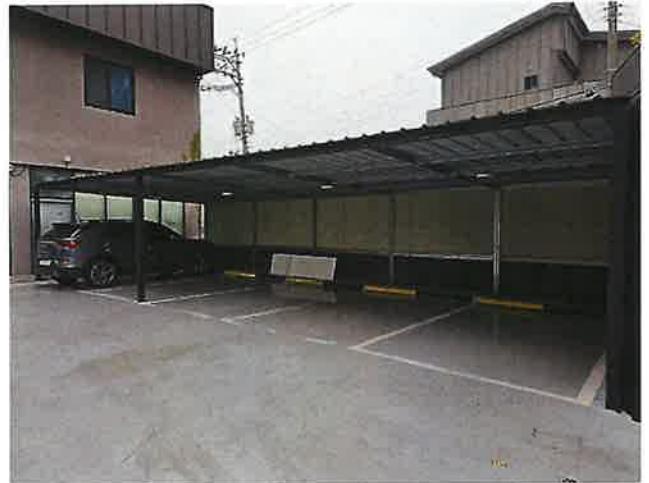
일련번호 가 1층 주차장(경량철골구조)
